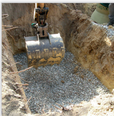
Wysypanie grysu – zwiększenie przepuszczalności
