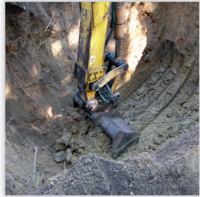
Przygotowanie wykopu pod oczyszczalnię
