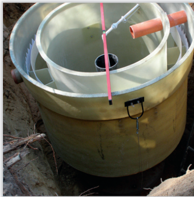
Kotwienie – stabilizacja oczyszczalni
