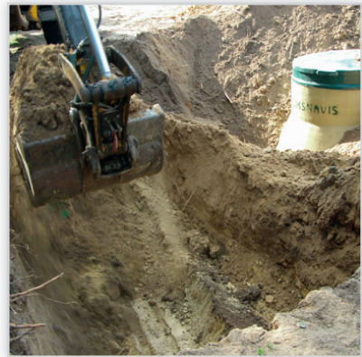
Wykop pod studnię chłonną
