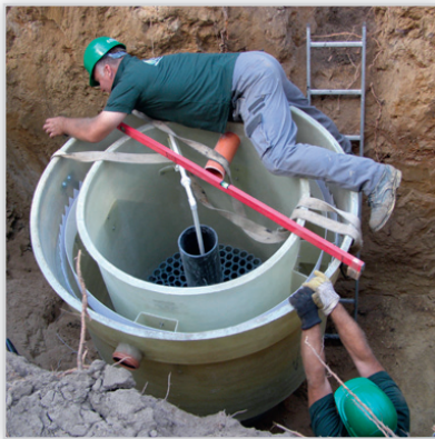
Poziomowanie oczyszczalni
