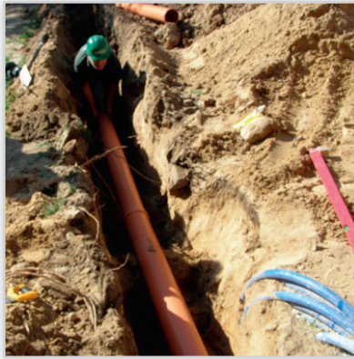
Układanie rury pcv z domu do oczyszczalni
